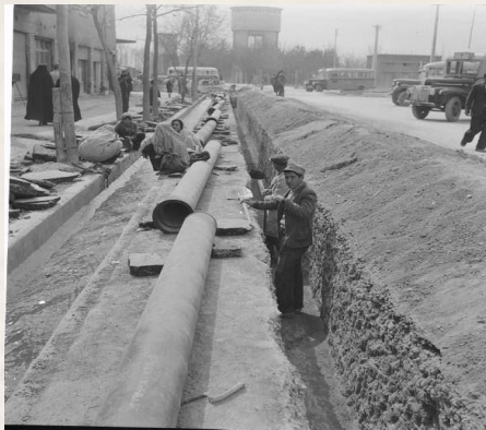
شکل ۳. لوله کشی آب شهر تهران، سال ۱۳۳۰. 61
